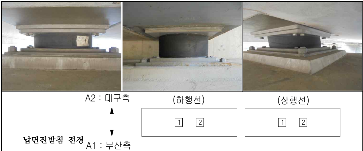
【사진 3.3.12】 교량받침 전경(부산)
