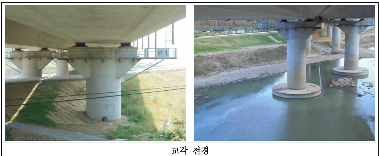
【사진 3.3.9】 교각 전경(부산)
