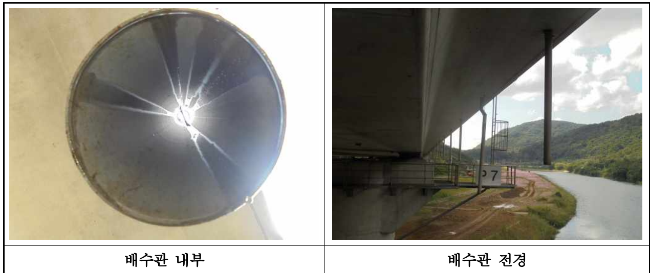
【사진 3.3.19】 배수구 및 배수관 전경(부산)
