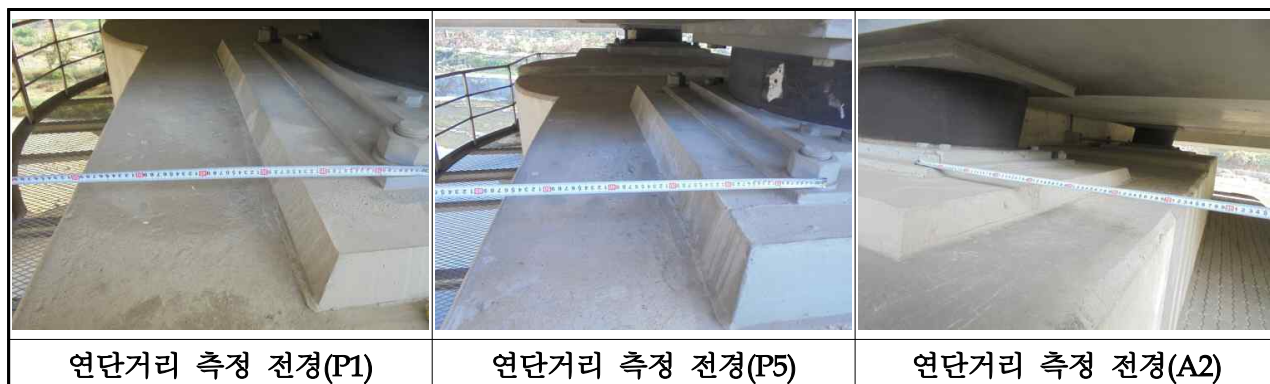
【사진 3.3.14】 연단거리 측정 전경(부산)
