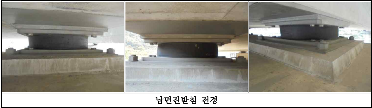
【사진 3.2.12】 교량받침 전경(대구)
