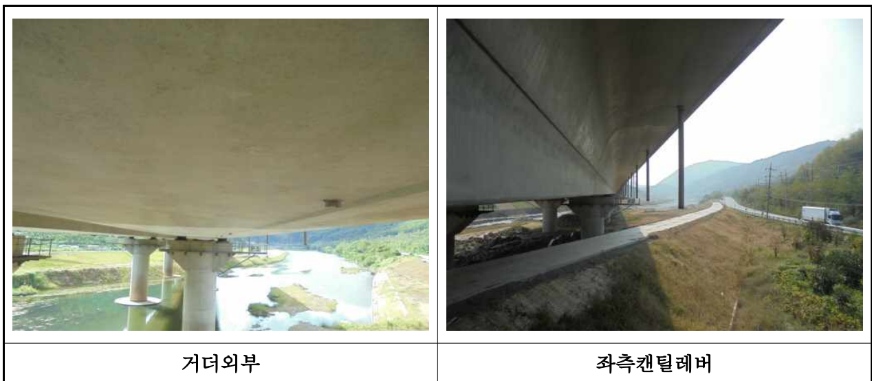
【사진 3.3.1】 거더 외부 전경(부산)
