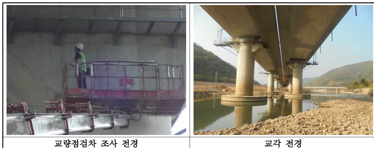
【사진 3.2.9】 교대 및 교각 전경(대구)
