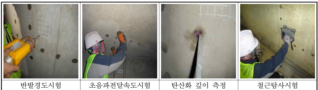
【사진 3.4.1】 콘크리트 내구성조사 전경
