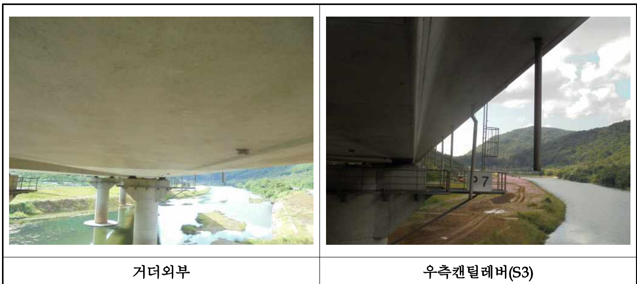
【사진 3.2.1】 거더외부 전경(대구)
